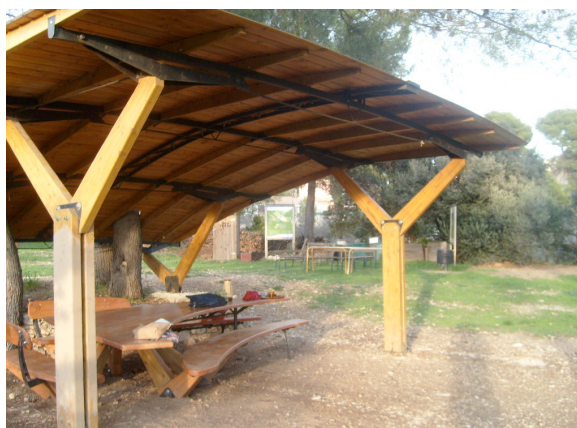
Jardin des Aures, abris réalisés par un chantier éducatif
